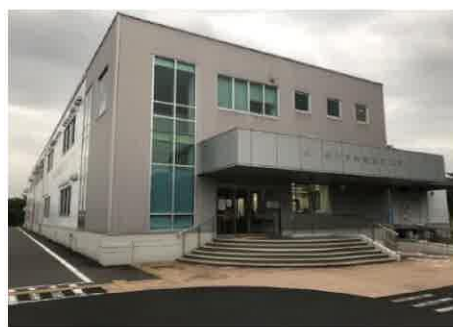
鶴ヶ島市学校給食センター
