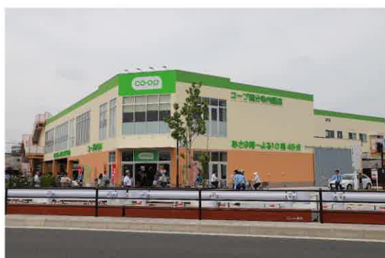
店舗から発生する食品廃棄物を 発電に活用しています
